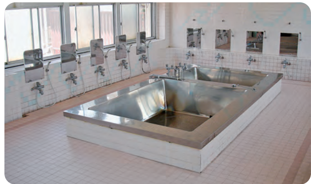
寮男子浴場 (管理棟) Bathhouse
